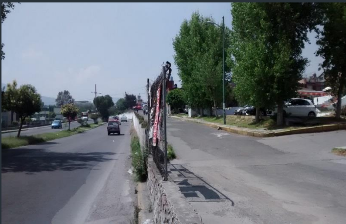
Muro de Rampa de Acceso.
