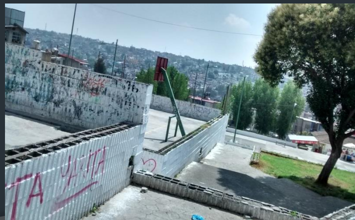
Muros interiores para canchas deportivas
