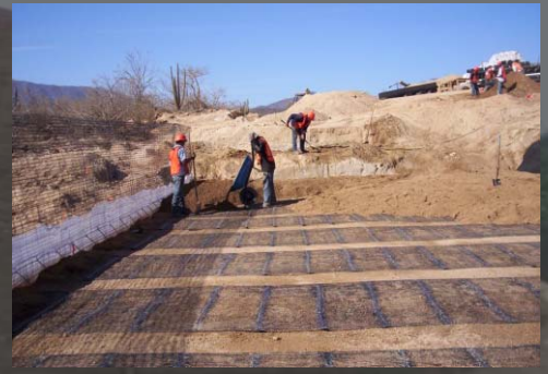
Instalación de refuerzos principales
