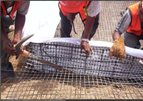
Colocación de parrilla metálica y filtro para formar la cara del muro
