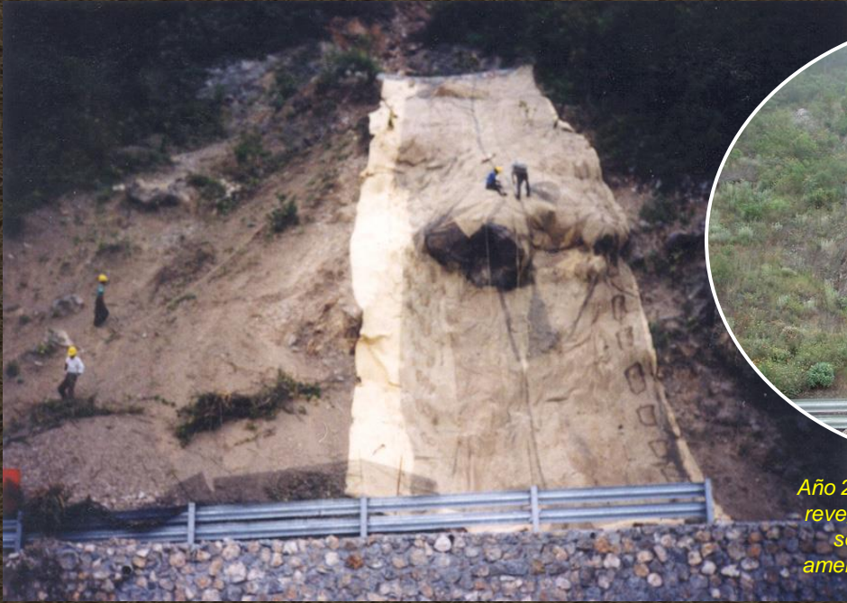
Año 1999: Protección con la malla BIOTEX® Coco reforzada, en un talud con historia de fallas continuas. Garza García, N.L..
