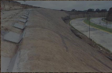
1. Instalación de BIOTEX® Coco reforzada, para contención de caídos y protección contra erosión. No se aplicó semilla
