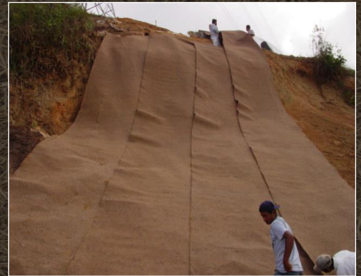
BIOTEX® Coco se suministra en rollos que se traslapan para dar continuidad a la protección, y sus extremos se atrapan en trincheras de anclaje. Mediante anclas metálicas, se sujeta la malla a la superficie del talud o corte.
