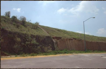
4. Al cabo de 36 meses, el predio vecino continúa erosionándose y no hay arbustos
